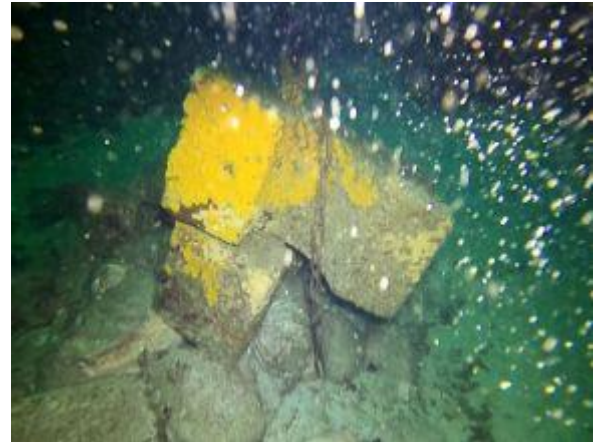
Abrazadera conectada por cadena a lastre en el fondo a los 1.050 metros sin observaciones
