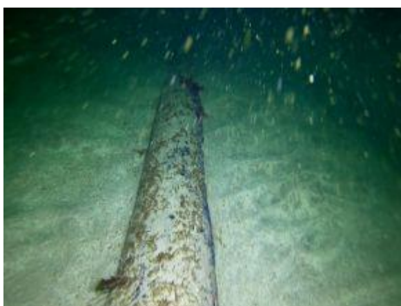
Tubería a lo largo de todo el emisario hermética
