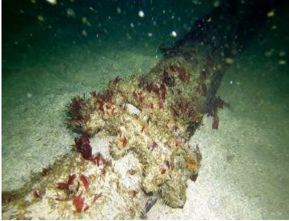
Unión N°1 de tubería hermética a los 840 metros (tiempo en video disponible en informe final)
