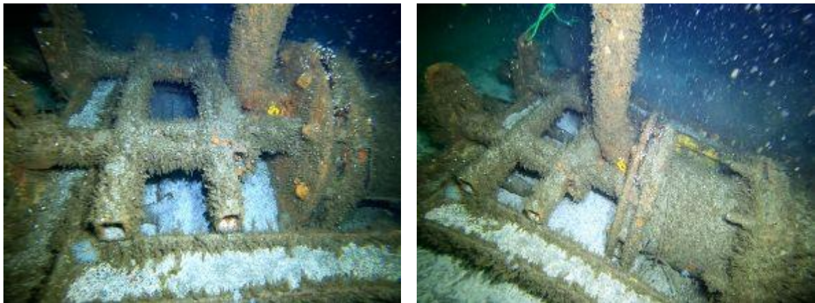
Tapa de registro sin fugas, con alto nivel de corrosión en pernos
