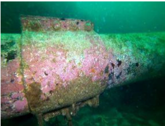
Abrazadera conectada por cadena a lastre en el fondo a los 1.290 metros sin observaciones
