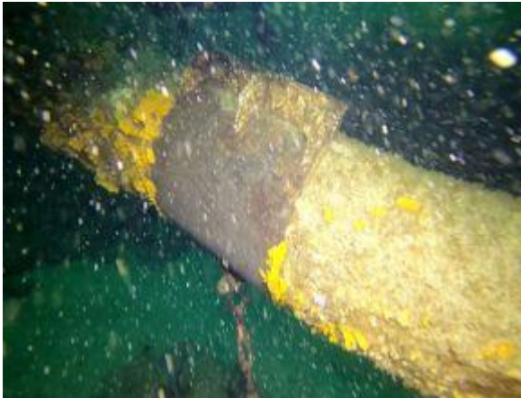
Abrazadera conectada por cadena a lastre en el fondo a los 1.050 metros sin observaciones
