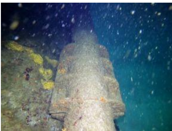
Abrazaderas de refuerzo apoyadas en rocas a los 700 y 1.150 metros sin observaciones
