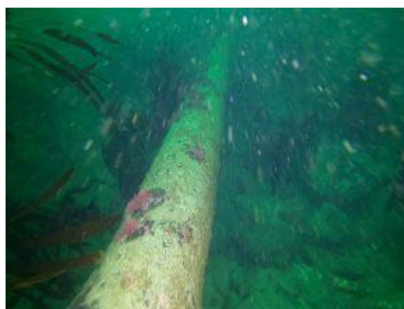
Tubería a lo largo de todo el emisario hermética
