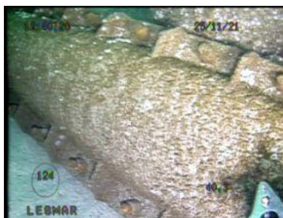
Abrazadera de refuerzo a 40 metros de profundidad sin observaciones.
