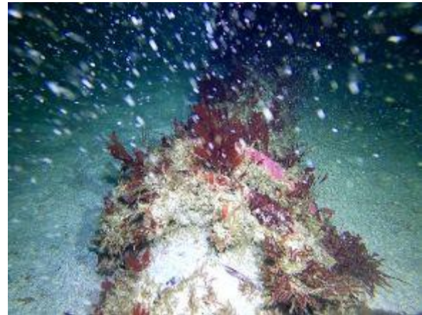
Unión N° 2 de tubería hermética a los 850 metros (tiempo en video disponible en informe final)
