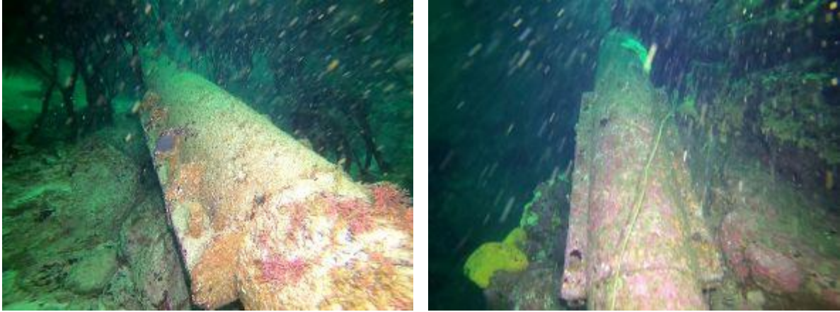
Abrazaderas de refuerzo a lo largo de todo el emisario sin fugas.
