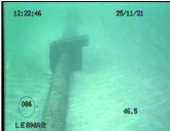
Lastre virado a 47 metros de profundidad
