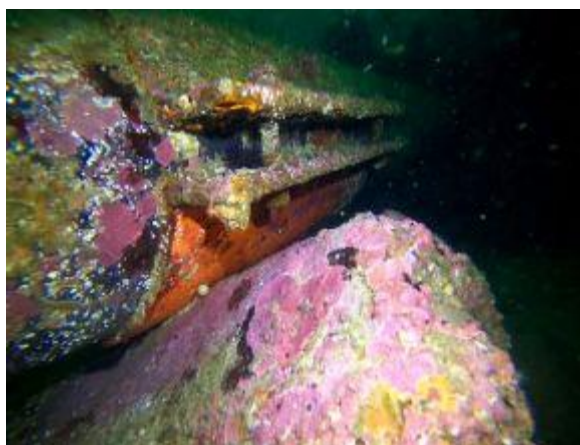
Abrazaderas de refuerzo apoyadas en rocas a los 700 y 1.150 metros sin observaciones
