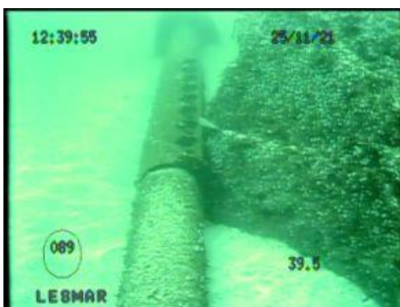
Abrazadera de refuerzo a 40 metros de profundidad sin observaciones.
